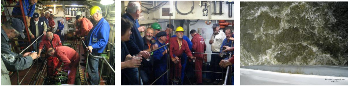
Erfolgreicher Probelauf der Hauptmaschine am 05.10.
